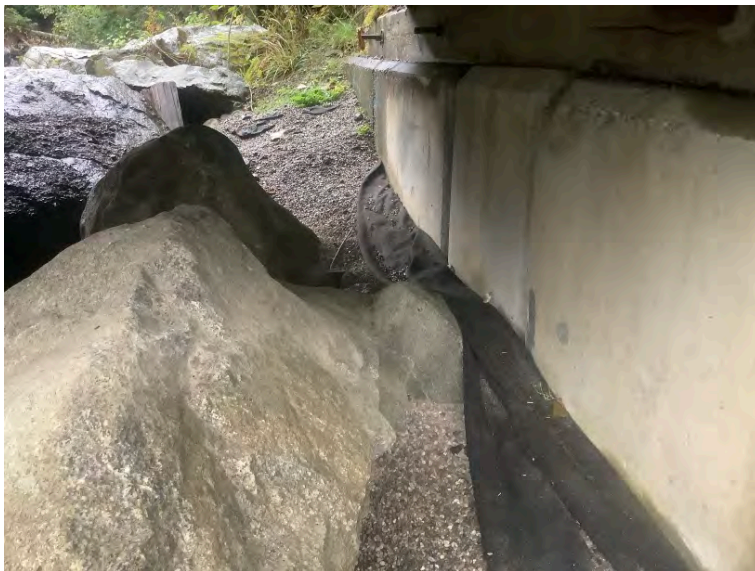
Re,edible fill beneath blocks
